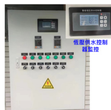
安裝後熱水控制系統
