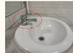
更換前 提按式水龍頭，有時候因忘關水龍頭造成水資源浪費。
