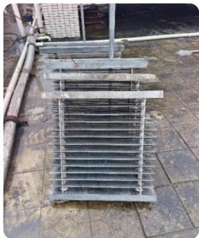
飯堂油煙淨化裝置清洗
