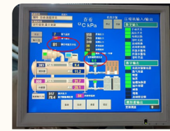
調整前冷凍水設定溫度8°C，主機負載81%
