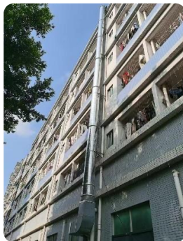
飯堂油煙管道更換
