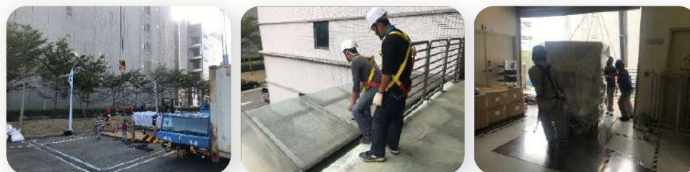
承攬商施工情況
